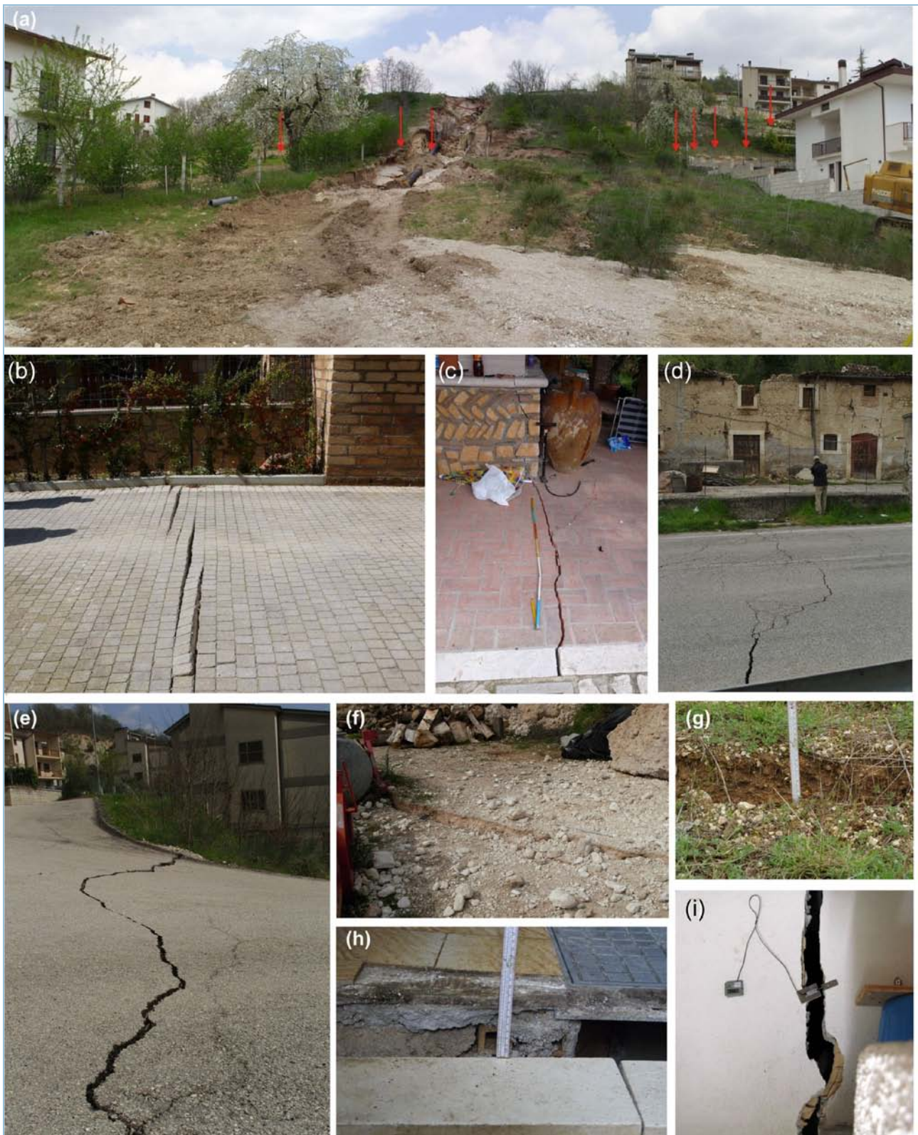
Figura 14.3: Dettaglio delle rotture prodotte dalla fagliazione superficiale a Paganica
