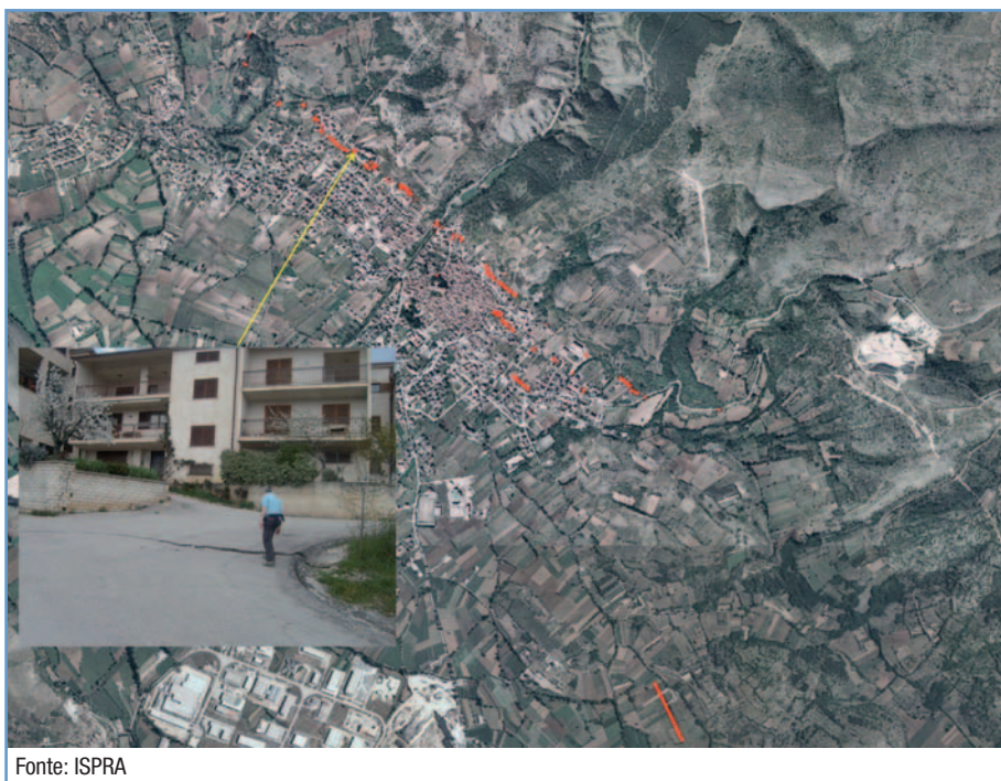
Figura 14.2: Fratturazione al suolo prodotta dal terremoto aquilano del 6 aprile 2009 nell'area dell'abitato di Paganica (L'Aquila)
