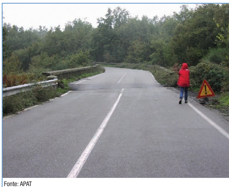
Figura 14.3: Danni provocati dalla dislocazione per creep della faglia Pernicana (trascorrente sinistra) alla infrastruttura viaria nei pressi di S. Alfio (CT)
