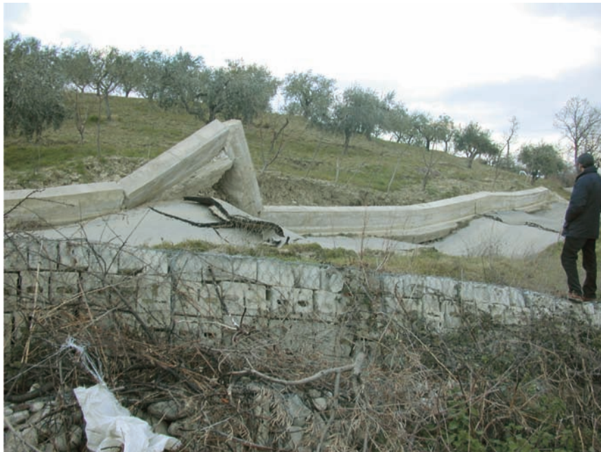
Figura 17.13: Movimento franoso nei pressi dell'abitato di Palata (CB). Deformazione della sede stradale e di una preesistente gabbionata a seguito dell'alluvione del gennaio 2003 (foto del 2003)
