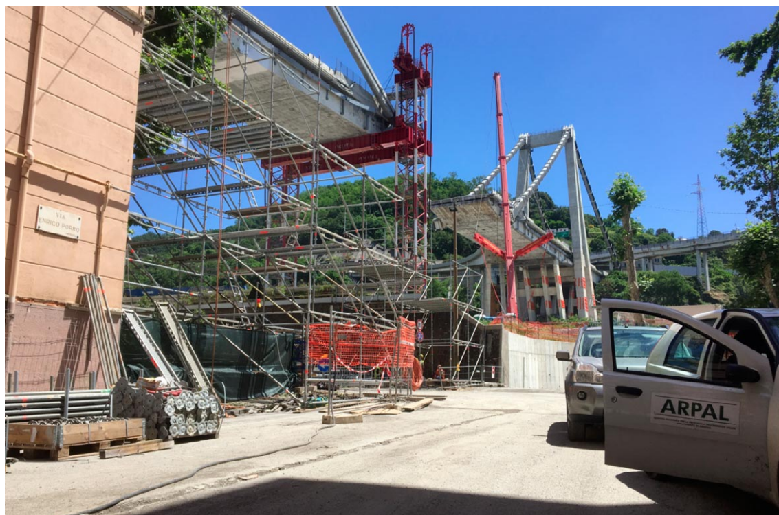
Figura 1: Sopralluogo ARPAL presso il cantiere della demolizione
